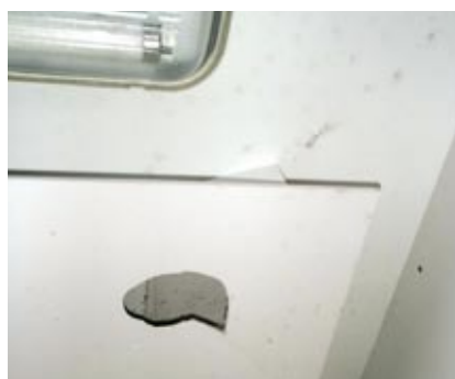
Dégâts occasionnés dans le plafond de la sorbonne par l'explosion.
