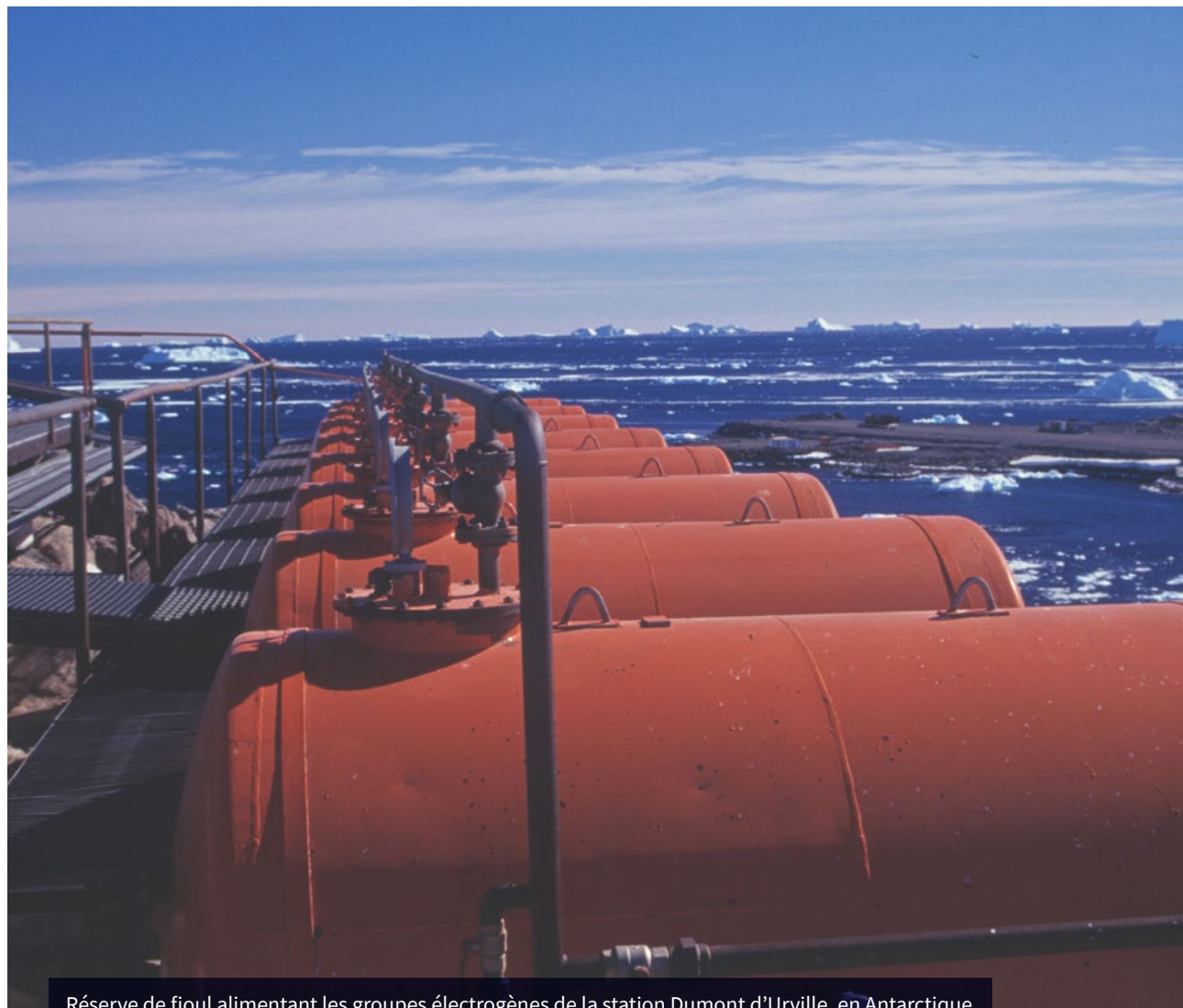
Réserve de fioul alimentant les groupes électrogènes de la station Dumont d'Urville, en Antarctique
