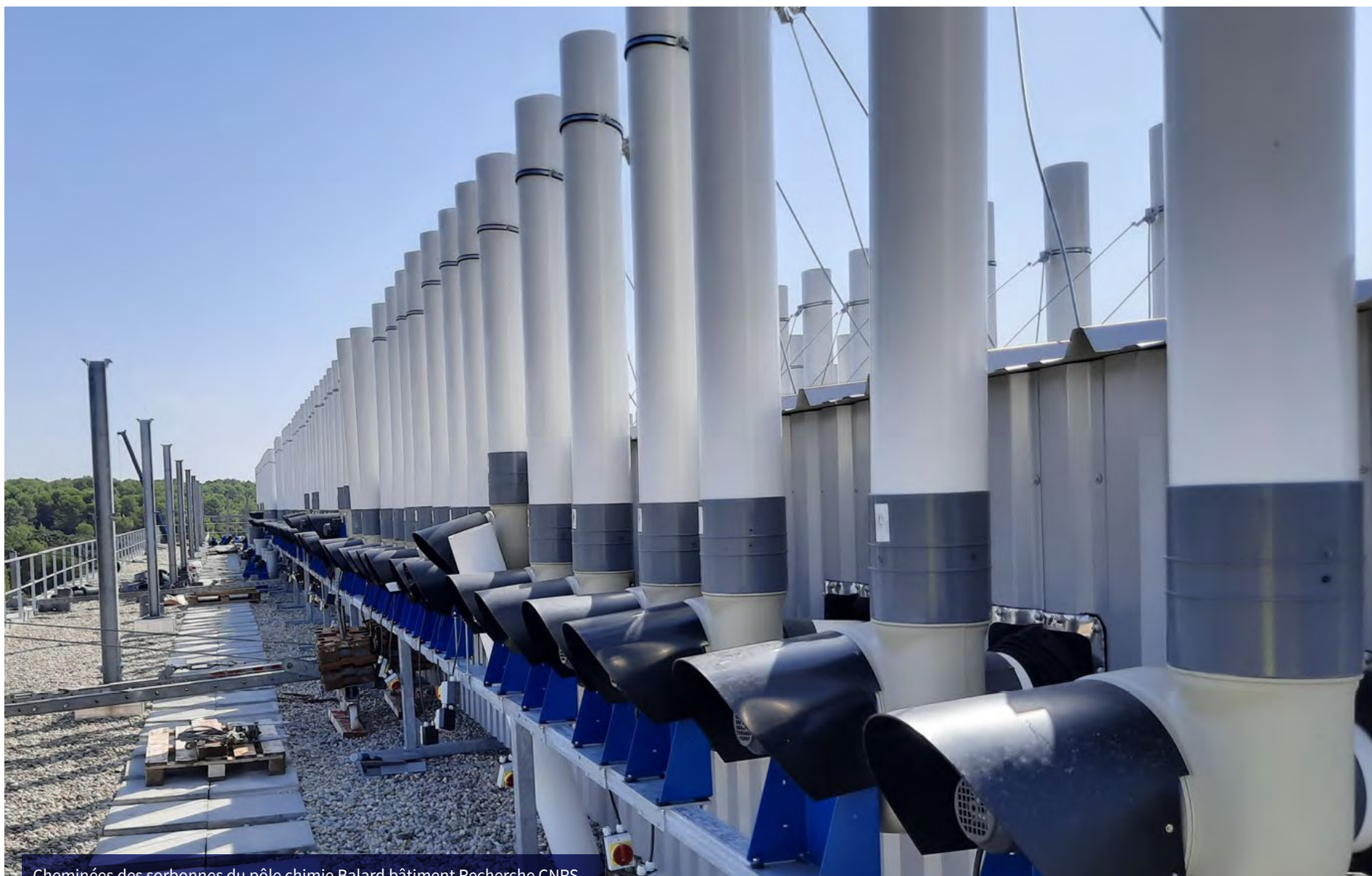
Cheminées des sorbonnes du pôle chimie Balard bâtiment Recherche CNRS
